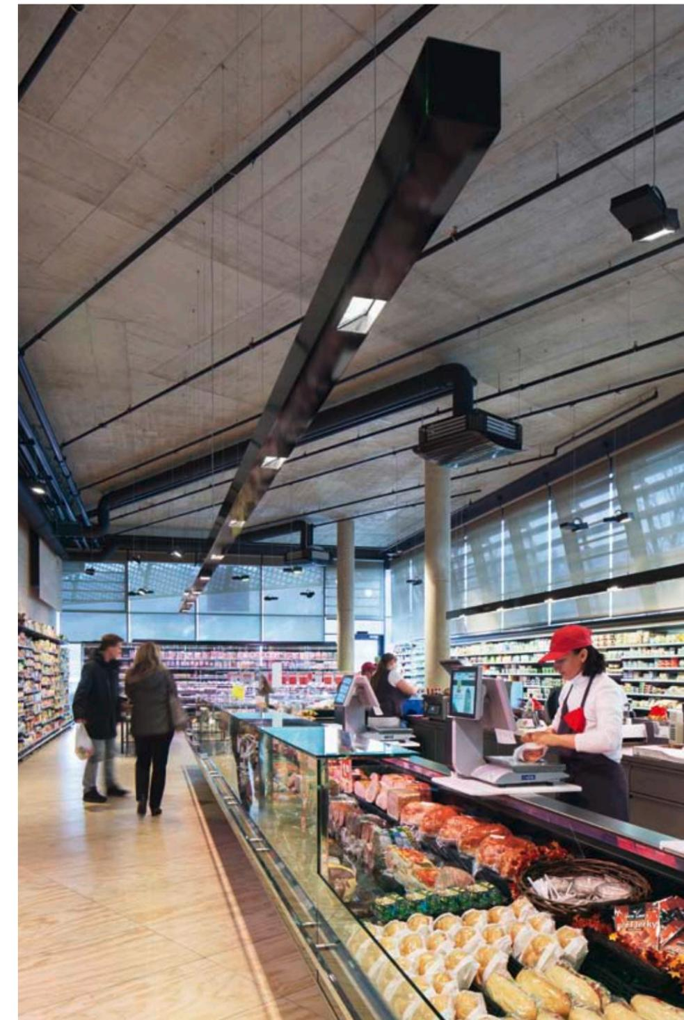
Aufbaustrahler Ontero ED 170 als Pendelleuchte (eine Sonderlösung, die in Österreich vielfach eingesetzt wird), größtenteils 70 Watt BBS (HIT) mit BatWing-Reflektor
